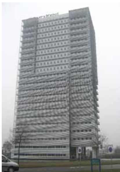
-Figuur 2- Kantoorgebouw 'La Tour' in Apeldoorn.
