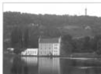
Obr. 11 Sovovy mlýny po rekonstrukci
