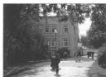
Obr. 10 Budova a galerie po rekonstrukci
